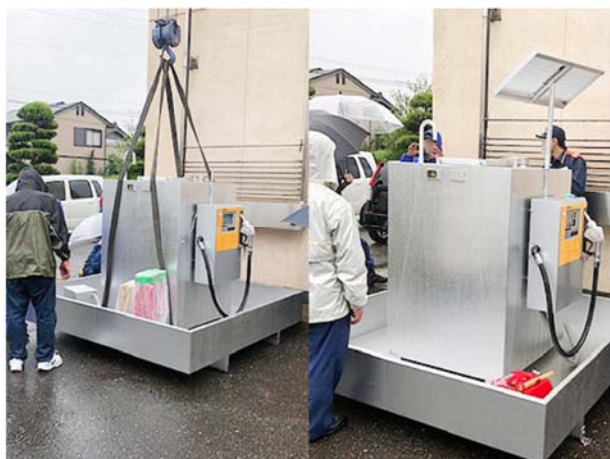
設置作業時の風景です。
